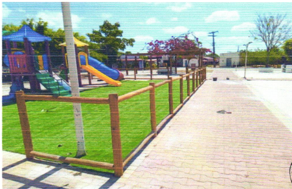
Foto 06 - FORNECIMENTO E MONTAGEM DE CERCA DE PROTEÇÃO EM EUCALIPTO CLOEZIANA TRATADO A BASE DE CCA EM AUTOCLAVE, COM APLICAÇÃO DE STAIN NA COR NATURAL COM DUPLO FILTRO SOLAR, DIAMETRO DO EUCALIPTO DE 6 A 8 CM, COM ANTI-RACHA NA EXTREMIDADE. FECHAMENTO COM TELA DE ALAMBRADO FIO Nº 12 REVESTIDO DE PVC, MALHA 2.1/2 X 2.1/2", FIXADO COM FIO Nº 14 REVESTIDO EM PVC, MÓDULO MEDINDO 1,50 X 1,00M, PARAFUSOS GALVANIZADOS COM TRAVAMENTO CLICKFIX, CONFORME PROJETO
