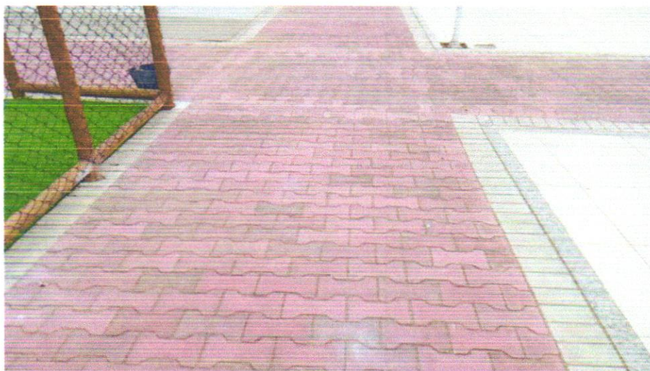
Foto 04 - PINTURA DE PISO COM TINTA ACRÍLICA, APLICAÇÃO MANUAL, 2 DEMÃOS, INCLUSO FUNDO PREPARADOR. AF_05/2021
