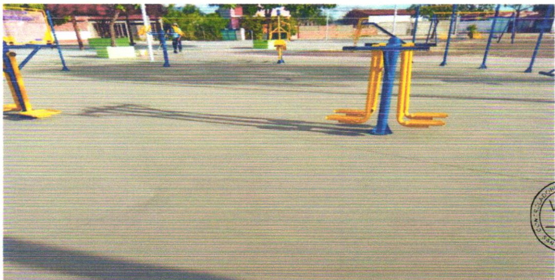
Foto 10 - PINTURA DE PISO COM TINTA ACRÍLICA, APLICAÇÃO MANUAL, 2 DEMÃOS, INCLUSO FUNDO PREPARADOR. AF_05/2021
