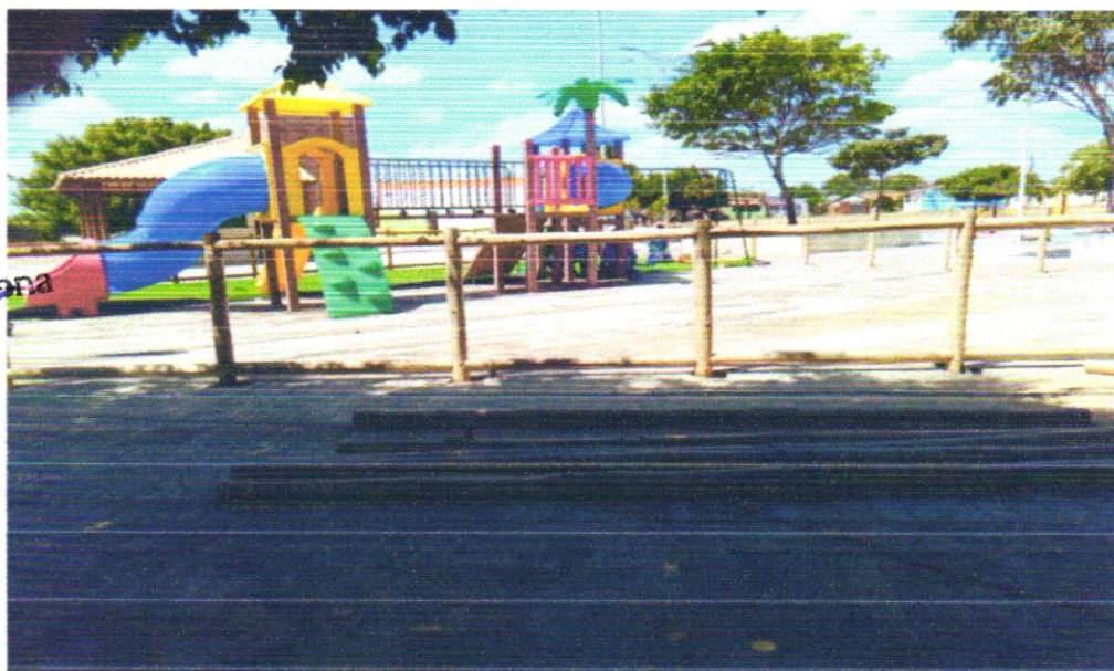
Foto 14 - FORNECIMENTO E MONTAGEM DE CERCA DE PROTEÇÃO EM EUCALIPTO CLOEZIANA TRATADO A BASE DE CCA EM AUTOCLAVE, COM APLICAÇÃO DE STAIN NA COR NATURAL COM DUPLO FILTRO SOLAR, DIAMETRO DO EUCALIPTO DE 6 A 8 CM, COM ANTI-RACHA NA EXTREMIDADE. FECHAMENTO COM TELA DE ALAMBRADO FIO Nº 12 REVESTIDO DE PVC, MALHA 2.1/2 X 2.1/2", FIXADO COM FIO Nº 14 REVESTIDO EM PVC, MÓDULO MEDINDO 1,50 X 1,00M, PARAFUSOS GALVANIZADOS COM TRAVAMENTO CLICKEFIX, CONFORME PROJETO
