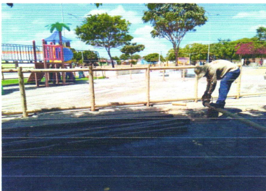
Foto 01 -FORNECIMENTO E MONTAGEM DE CERCA DE PROTEÇÃO EM
