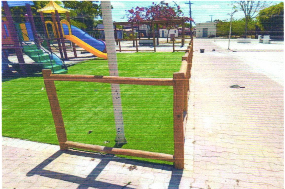
Foto 09 - FORNECIMENTO E MONTAGEM DE CERCA DE PROTEÇÃO EM EUCALIPTO CLOEZIANA TRATADO A BASE DE CCA EM AUTOCLAVE, COM APLICAÇÃO DE STAIN NA COR NATURAL COM DUPLO FILTRO SOLAR, DIÂMETRO DO EUCALIPTO DE 6 A 8 CM, COM ANTI-RACHA NA EXTREMIDADE. FECHAMENTO COM TELA DE ALAMBRADO FIO Nº 12 REVESTIDO DE PVC, MALHA 2.1/2 X 2.1/2", FIXADO COM FIO Nº 14 REVESTIDO EM PVC, MÓDULO MEDINDO 1,50 X 1,00M, PARAFUSOS GALVANIZADOS COM TRAVAMENTO CLICKFIX, CONFORME PROJETO
