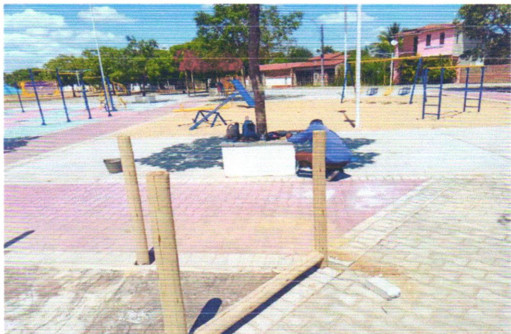
Foto 08 - FORNECIMENTO E MONTAGEM DE CERCA DE PROTEÇÃO EM EUCALIPTO CLOEZIANA TRATADO A BASE DE CCA EM AUTOCLAVE, COM APLICAÇÃO DE STAIN NA COR NATURAL COM DUPLO FILTRO SOLAR, DIAMETRO DO EUCALIPTO DE 6 A 8 CM, COM ANTI-RACHA NA EXTREMIDADE. FECHAMENTO COM TELA DE ALAMBRADO FIO Nº 12 REVESTIDO DE PVC, MALHA 2.1/2 X 2.1/2", FIXADO COM FIO Nº 14 REVESTIDO EM PVC, MÓDULO MEDINDO 1,50 X 1,00M, PARAFUSOS GALVANIZADOS COM TRAVAMENTO CLICKFIX, CONFORME PROJETO
